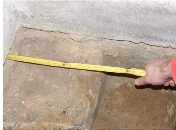
März 2010: Voruntersuchung durch den Statiker an den Fundamenten der tragenden Wände
